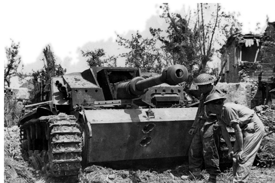
Британские солдаты смотрят на пробоины в лобовой броне немецкой САУ StuG III ausf. G. Район Кассино (Cassino), «линия Гитлера», 18 мая 1944 года.
